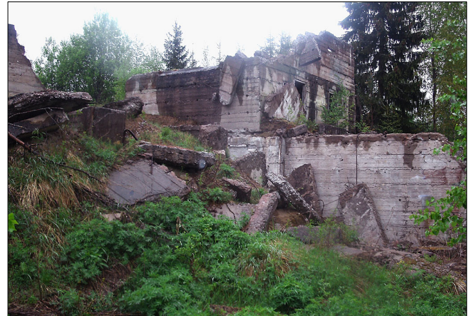
Рис. 8.4. Типичные разрушенные сооружения на закрытых объектах специального назначения. Ранг 2. Федеральный объект
